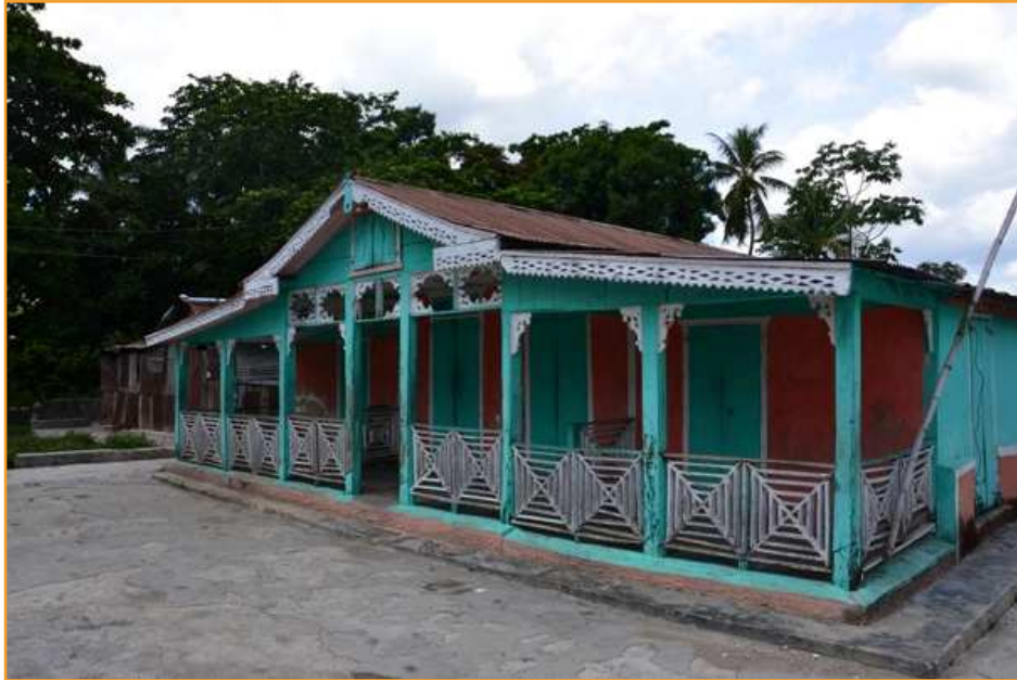
Maison en structure bois « moderne » composée d'un corps principal et de deux corps latéraux – Vialet
