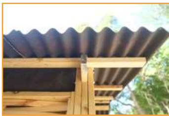
Tôle Onduline bitumée utilisée par Handicap International
