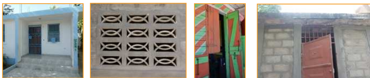
Dispositifs de fermeture « solide » fréquents en Haïti : grilles, claustras, charnières et crochets en ferronnerie, portes métalliques
