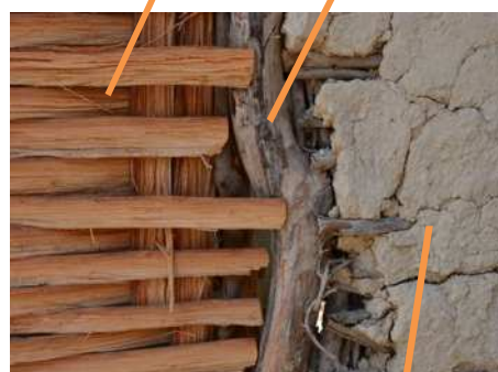
Clissage + mortier et enduit à la chaux
