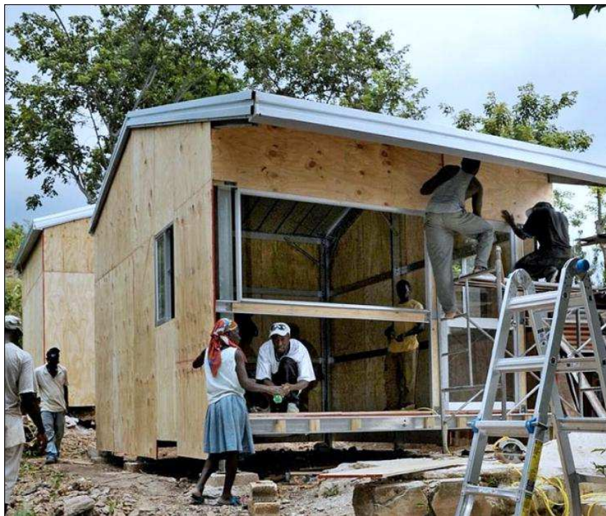
T-shelter Croix-Rouge Suisse en construction Structure en aluminium galvanisé – crédit photo CRS
