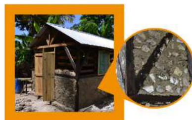
Maçonnerie de pierres Medair à Jacmel
