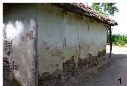
Clissage + mortier et enduit à la chaux
