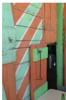
Fermeture par crochets et charnières forgées
