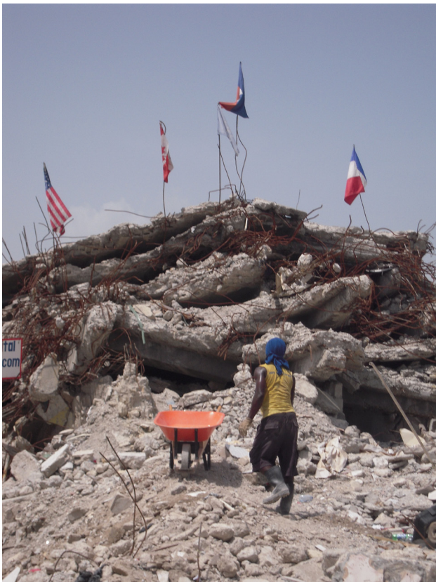
Port-au-Prince, juillet 2010 : un Haïtien déblayant les gravats à mains nues (Photo : E. SAUVIGNET/CHF)
